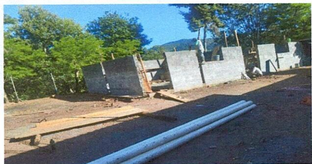
Foto 3: mejoramiento de paredes de modulos
