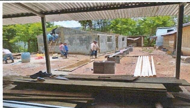
Foto 2: mejoramiento de modulos con estructuras y techo troquelado
