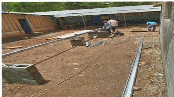
Foto1: mejoamiento de estructura metalica de modulos
